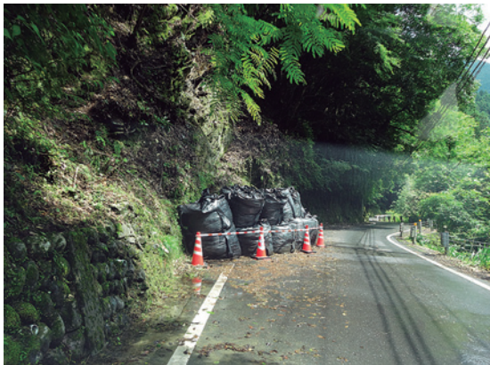
県道安居公園線（入江谷付近）
