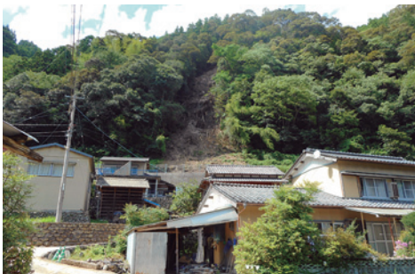
宮ヶ坪災害現場
