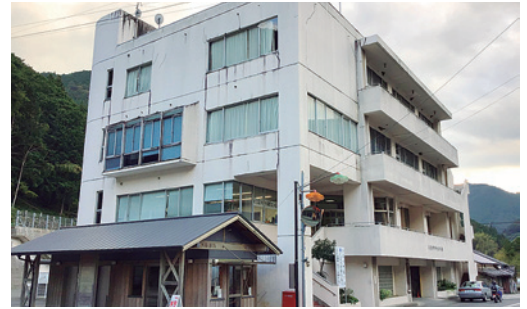
耐震化されていない中央公民館
