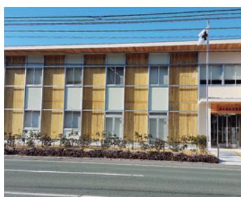
外壁のガラス越しにCLTパネルが見える外観(嶺北森林管理署)
