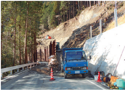
町道椿山線道路改良工事現場
