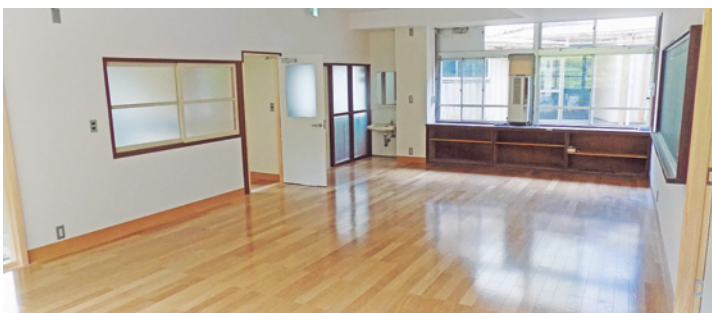
旧名野川小の教室を改修したシェアオフィス
