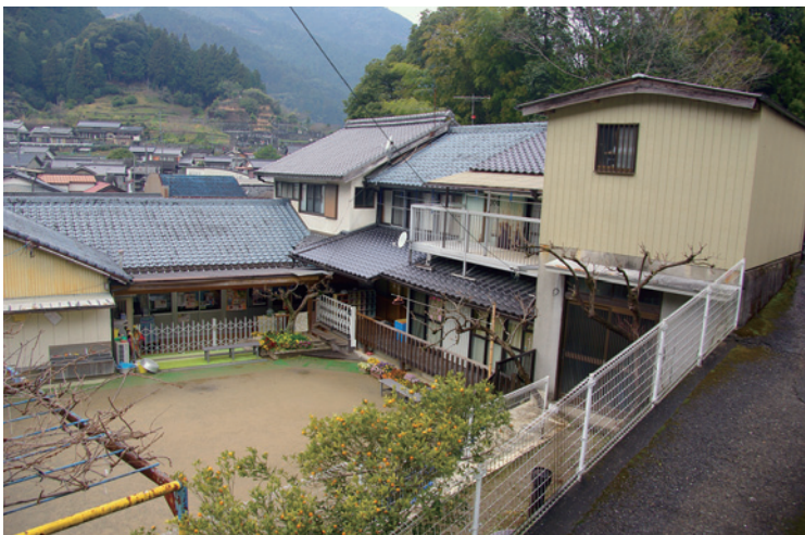
耐震不足、老朽化により建て替える池川保育園
