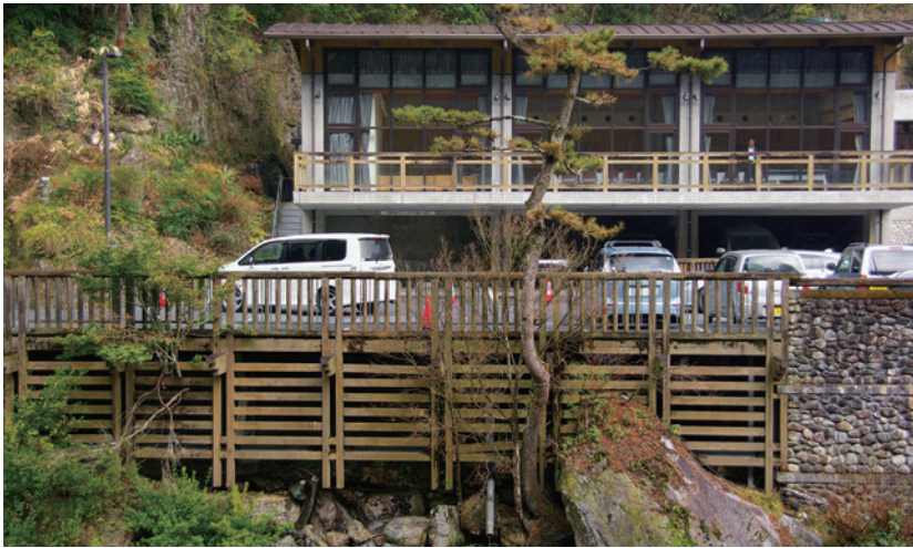
改修される「ゆの森」駐車場
