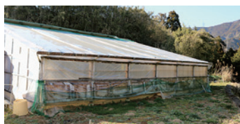
石垣トマトハウス
