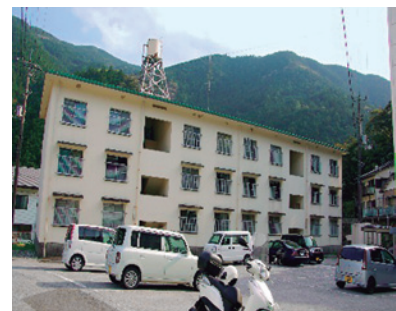
大崎診療所隣の町営住宅
