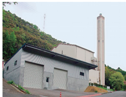
改修工事中の清掃センター
