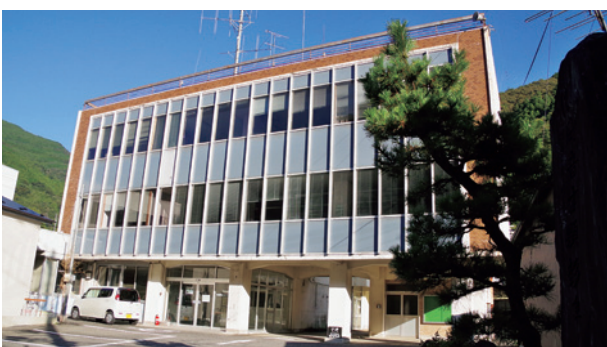
取り壊され、跡地に林業振興センター（仮称）を建設する旧庁舎
