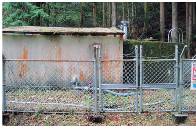
緩速ろ過池・昭和53年整備
