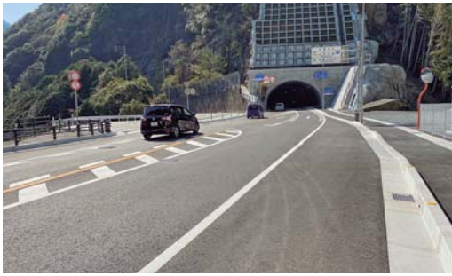
橋中津トンネル開通
