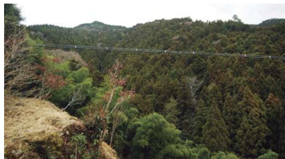
空中を經由する坂本配水区送水管
