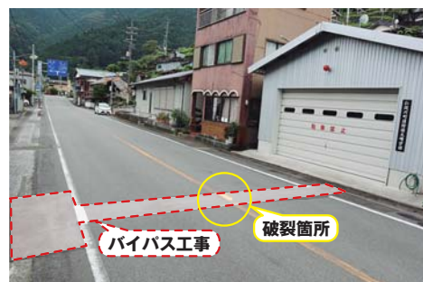
水道管破裂現場付近（川口）
