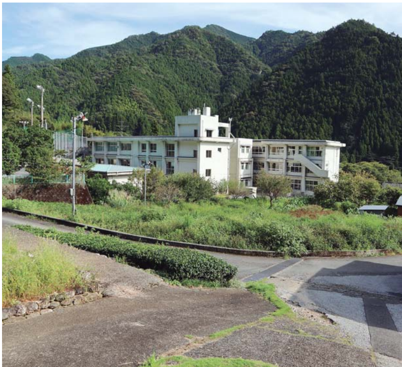
池川住宅予定地 1 工区
