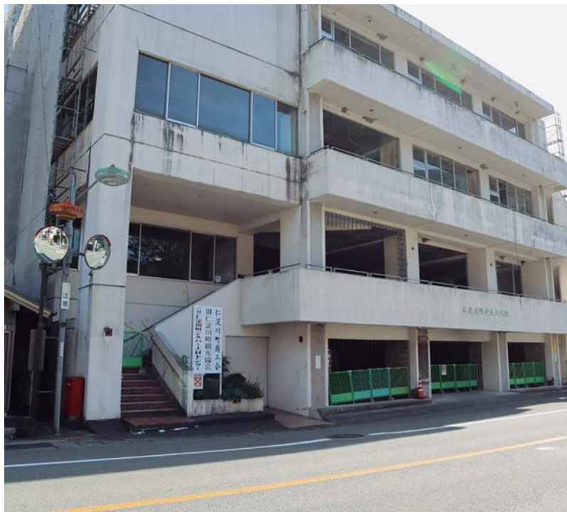
旧中央公民館（交流センター）改修工事状況
