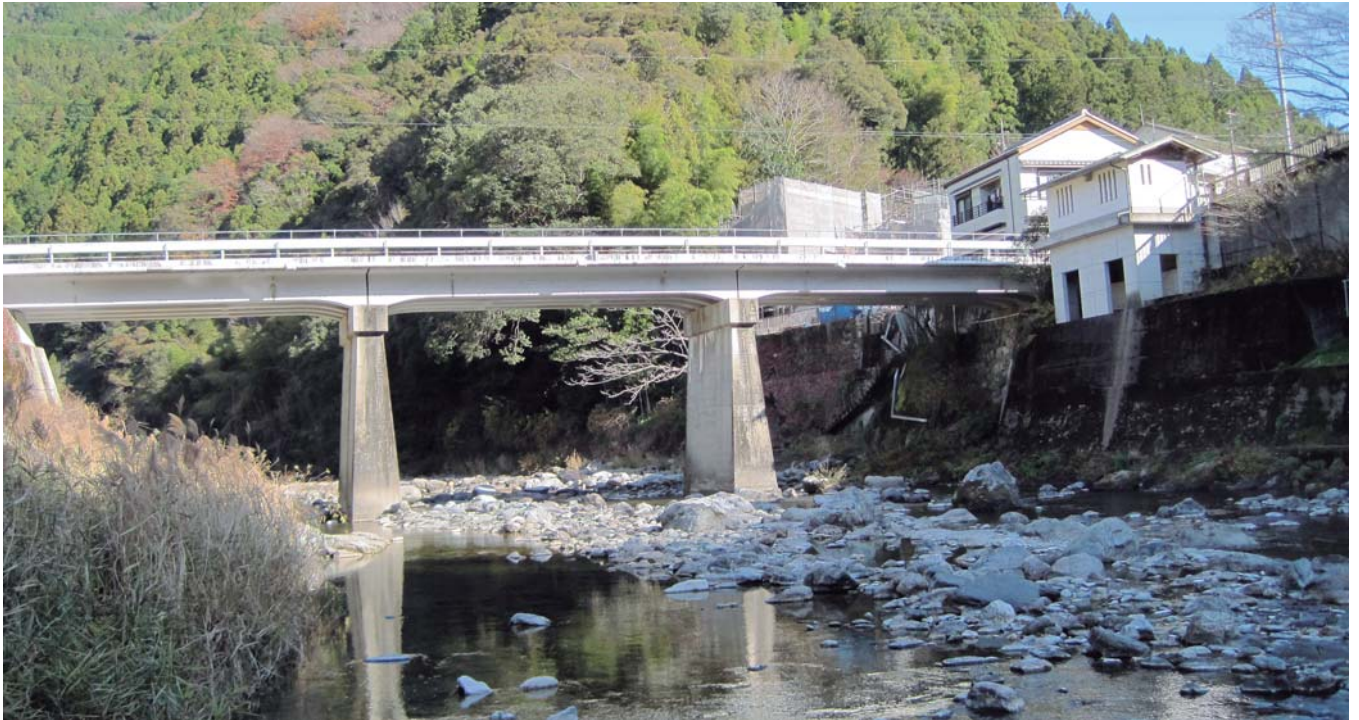
土居川橋 架設年数約80年
