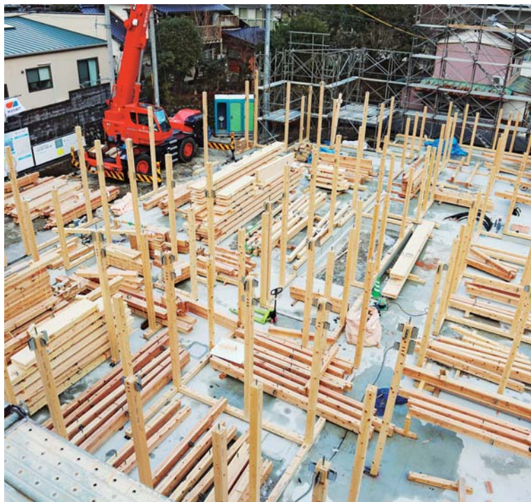
大崎診療所建替工事現場
