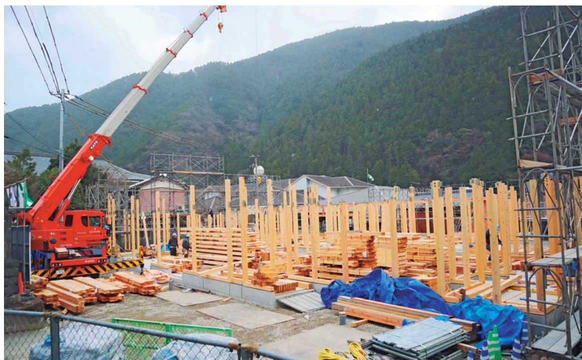
大崎診療所建替工事現場
