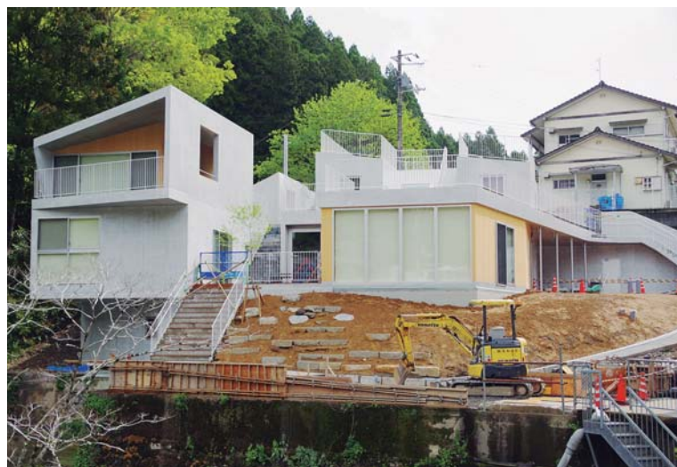
子どもたちに安全を 耐震不足により新築された池川保育園
