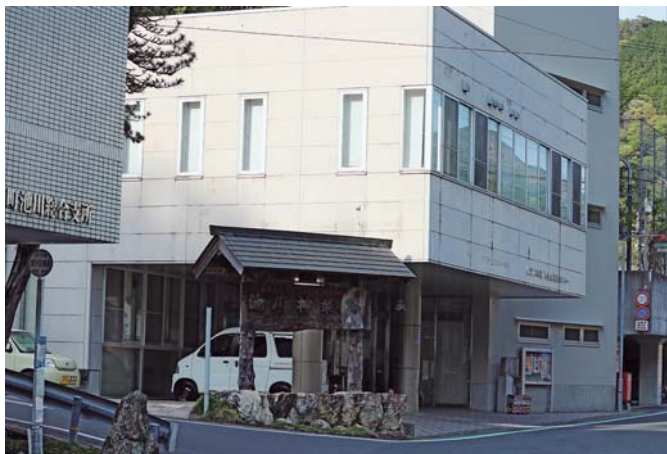
池川保健福祉センター改修工事
