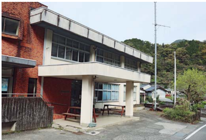
仁淀公民館解体事業
