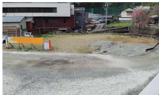
林業振興センター建設予定地（旧本庁舎跡地）
