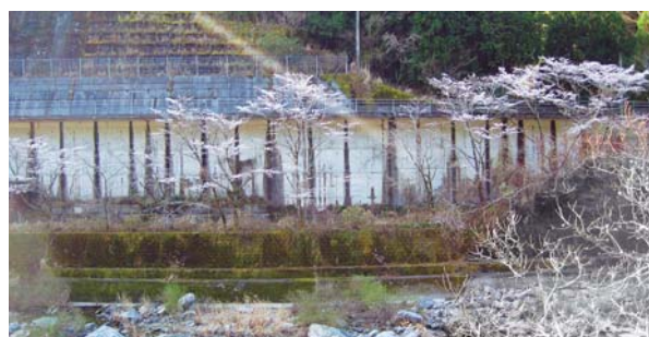
家古屋地区からみた国道439号側
