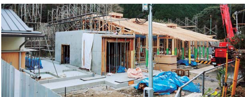
建設中の大崎診療所
