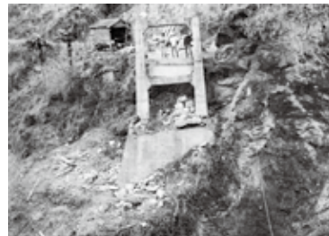
長坂橋旧橋取り壊し
