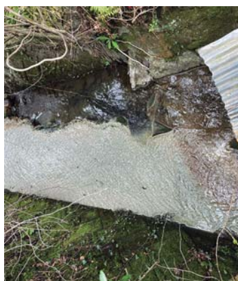
小郷川へ流れ込んでいる谷(白いヘドロが堆積している)
