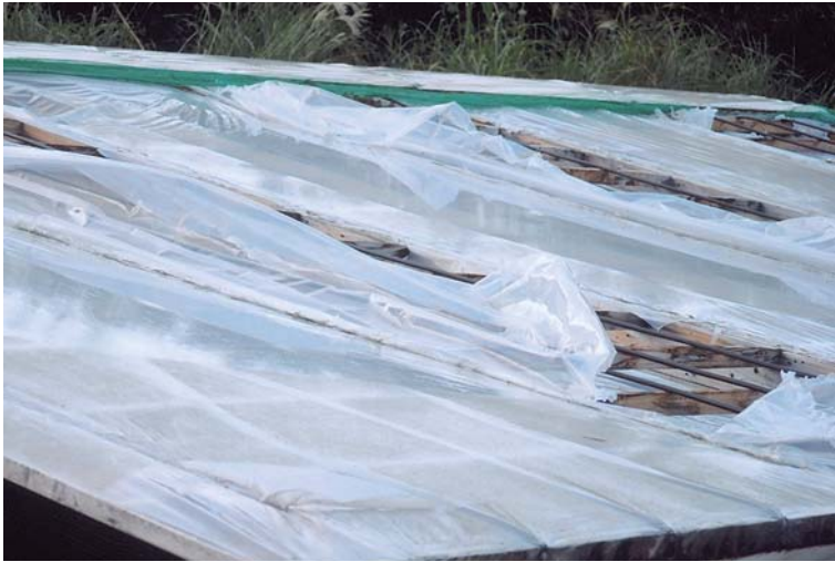
台風14号で被害を受けたビニールハウス
