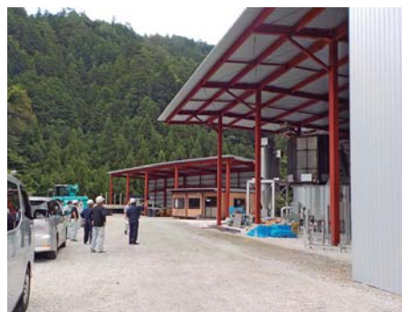
木こり屋バイオマス発電所
