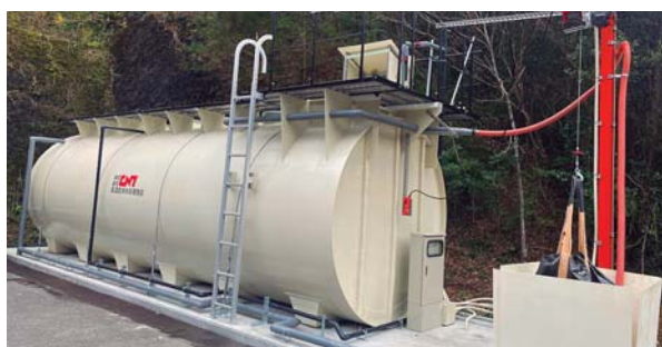
新設された高濃度排水処理槽
