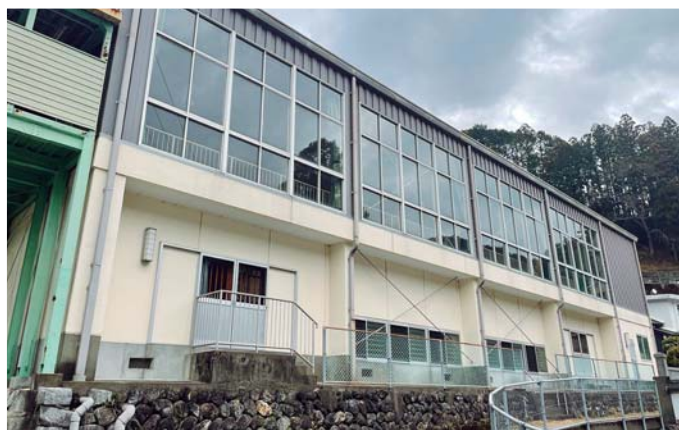
避難所（旧大崎小学校体育館）
