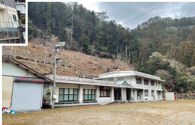
避難所（泉川多目的集会施設）
