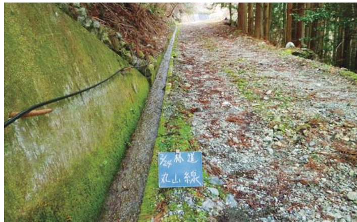
林道の除草状況
