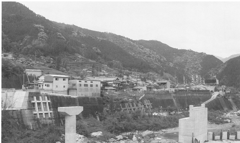
水量が減り5600万円で工事を行う田村地区。芸予地震が原因というが(田村)
