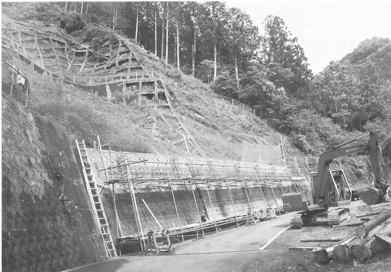
農道長屋線災害復旧工事現場（長屋）
