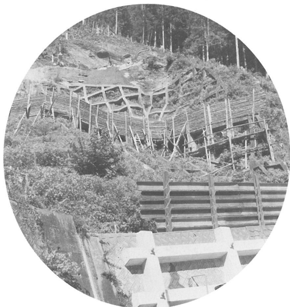
農道長者線災害復旧工事現場（長屋）
