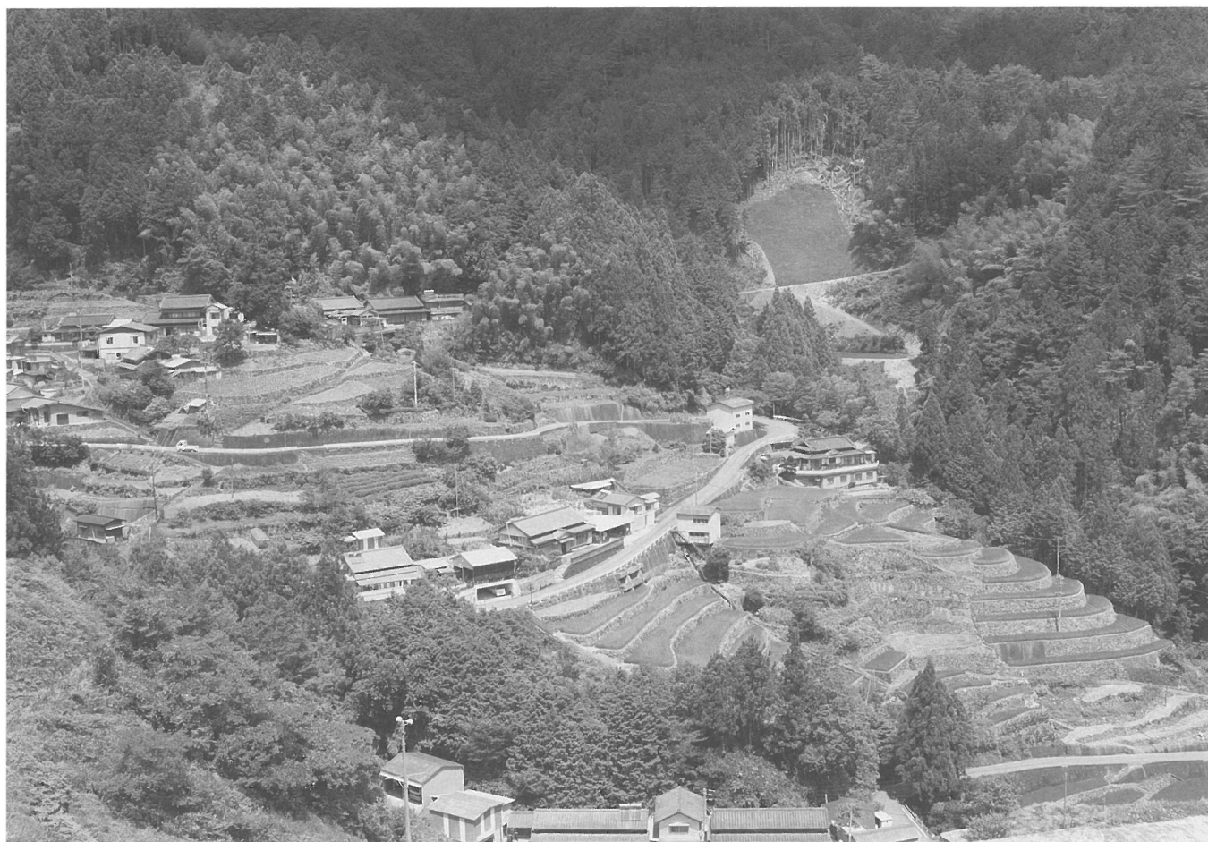
1日数百台の通行量があるが、舗装、路肩が痛み、補修が急がれる（大植）
