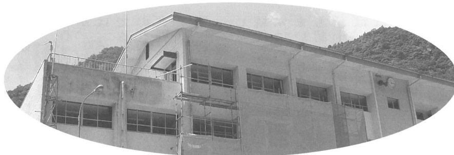
耐震改修工事 (名野川小)
