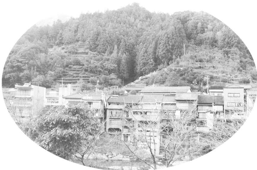
人家が密集している赤石谷川下流域、上部の防災対策が急がれる（土居）
