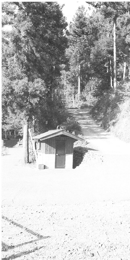
災害により通行止めとなり、住民が利用している迂回路（岩戸）
