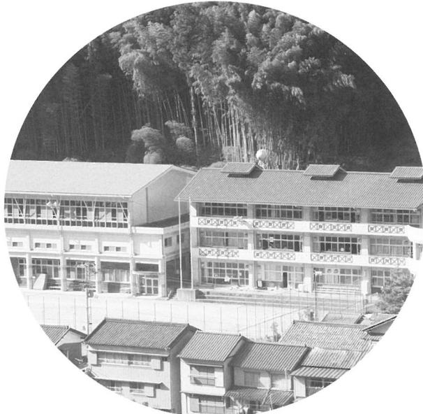
町内唯一、耐震工事を必要としない池川小(土居)
