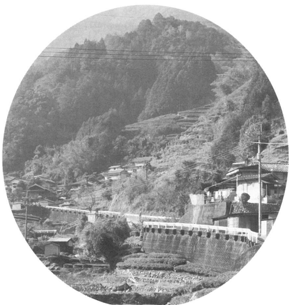
仁淀西谷地区飲料水供給施設
