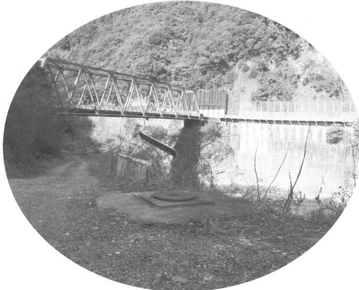
現在の給水施設（給食センター・原石山）
