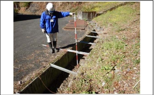
写真24 造成地北縁のU字コルゲート排水路(幅0.8m、深さ0.8m)。造成地東縁を流下していく。
