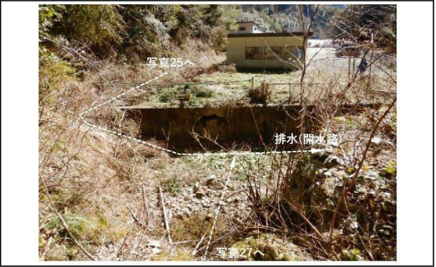
写真28 写真27の谷水は、写真25の谷水と合流後、造成地西縁を流下して排水される。
