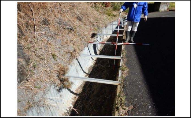
写真26 写真25の下流、造成地北縁のU字コルゲート排水路(幅1.0m、深さ0.8m)
