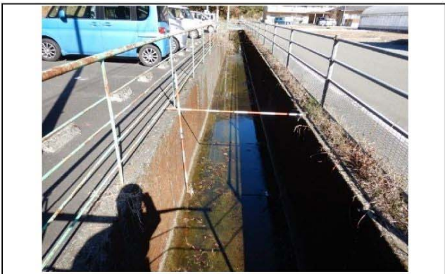
写真10 造成地西縁を流下するコンクリート排水路(幅1.8m、深さ1.5m)
