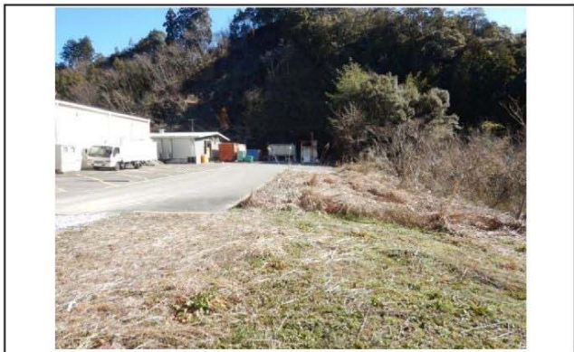
写真9 のり面天端に明瞭な変状はみられない
