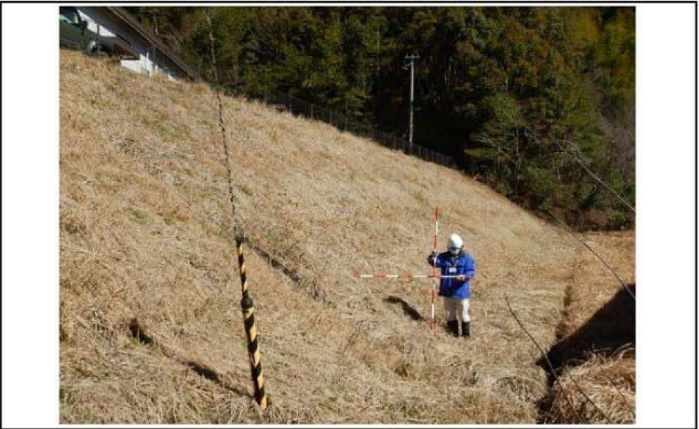
写真19 精密機械工場南側ののり面(のり高6~7m程度、勾配1:1.5)
