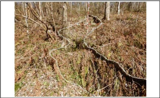
写真7 6段目のり面のガリ浸食(最大幅2m,深さ0.5m)(近傍には小崩壊(1.0×1.0×0.3m程度)もみられる)
