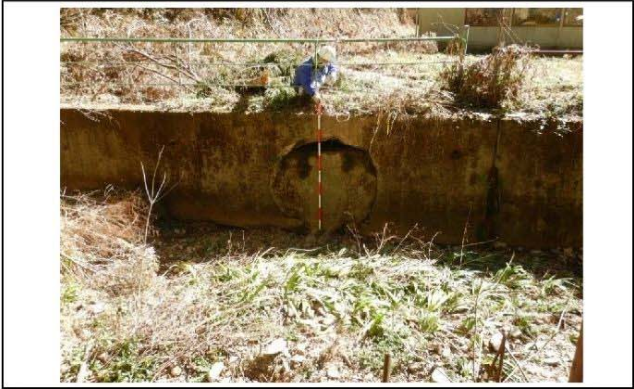
写真29 写真28拡大。Φ1400程度の暗渠が設置されているが、現在はコンクリートで閉塞されている。
