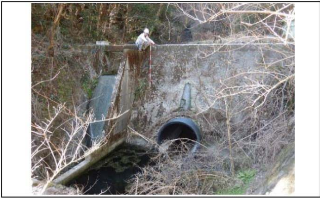
写真2 のり面最下段の重力式コンクリート擁壁工 (φ1350ポリエチレン管の暗渠あり)
