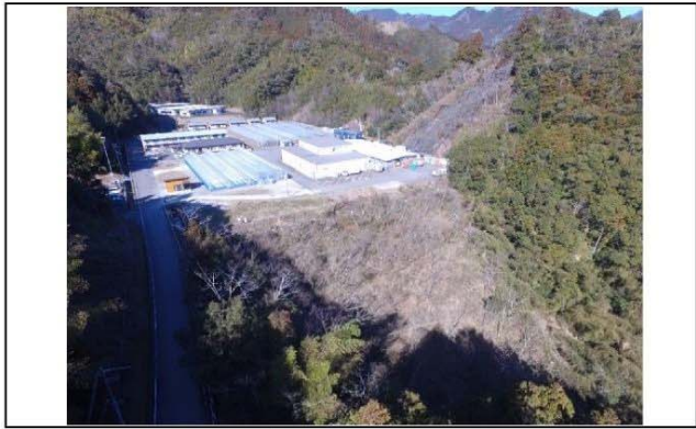
写真1 盛土造成地の全景(南西側より望む)
