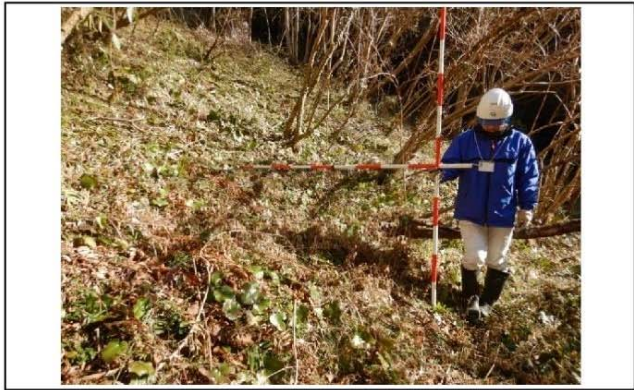
写真5 のり面の勾配 (1:1.8)
