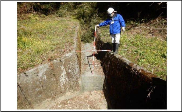
写真25 造成地に流入する2本の渓流のうち、東側渓流の流水処理状況。谷水は開水路に流入する。調査時に流水なし。
