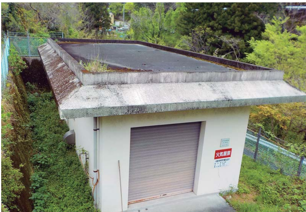
土居排水区 有実浄水場（岩丸）
