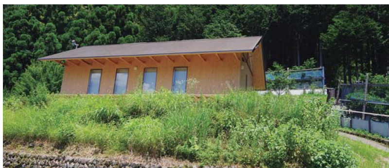
2工区の一部に建てられた町産材を利用したモデル住宅
