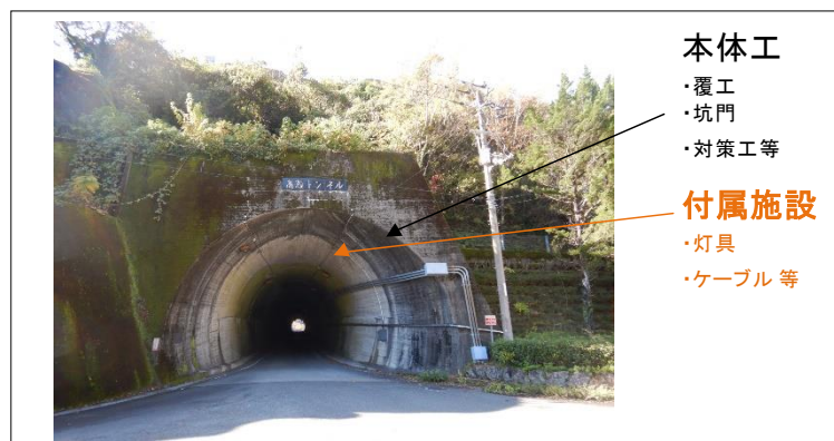
図-2 トンネル構造
