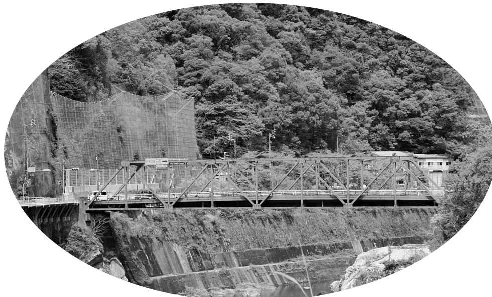
耐震補強工事を国に要望しているが（上仁淀橋）
