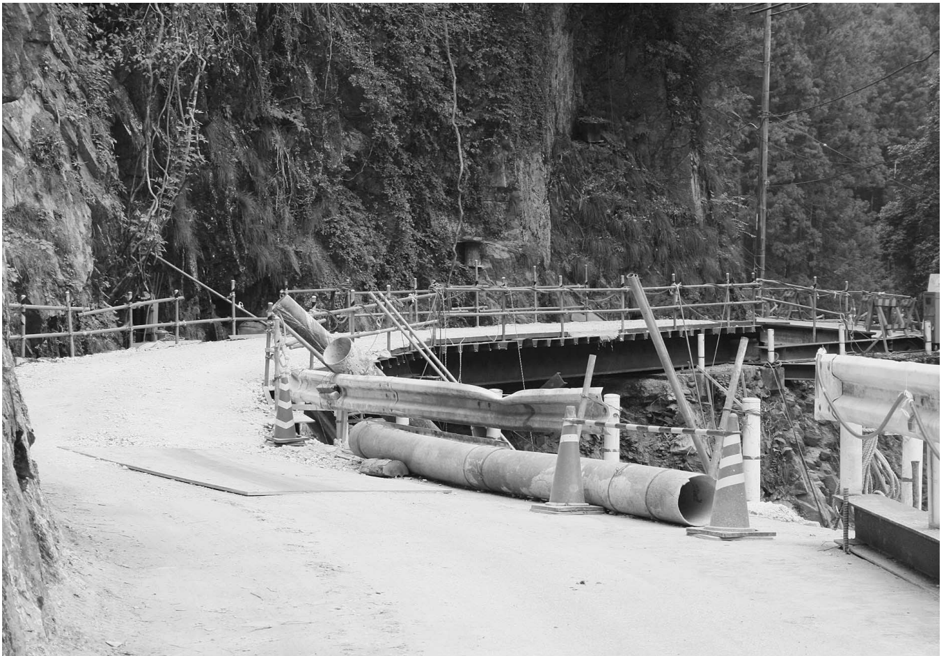
町道椿山線、総事業費3億円。5年間で整備する（百川内）
