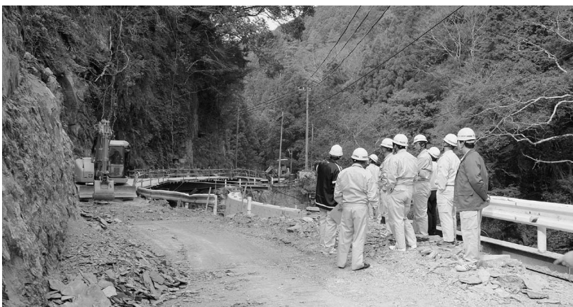
現地調査、19年11月町道椿山線(百川内)
