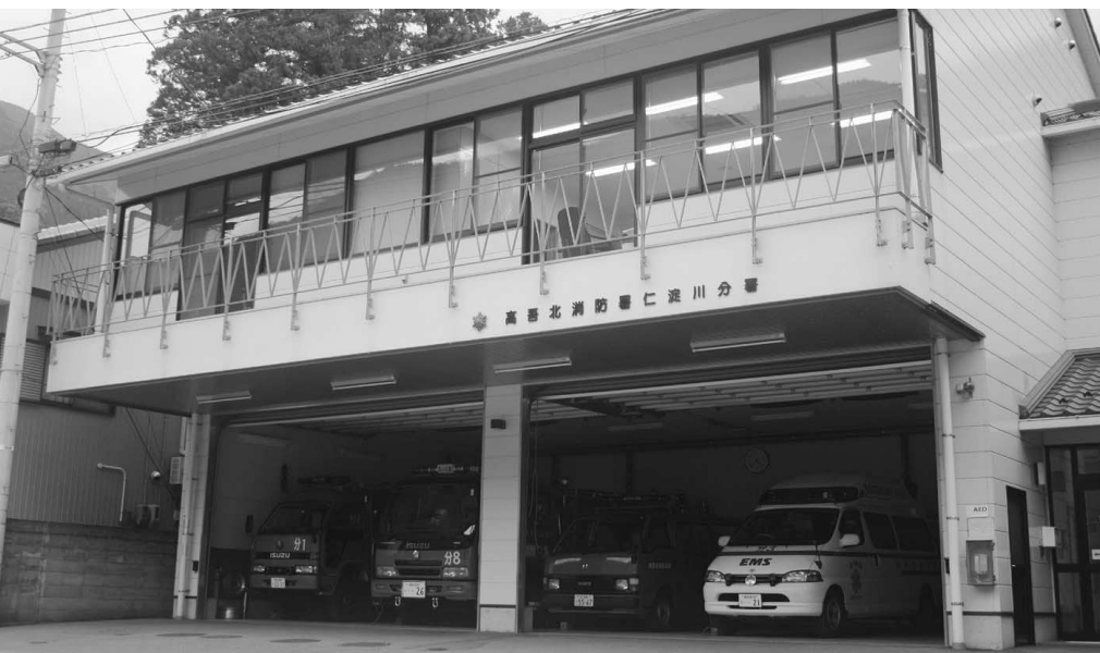
県一消防本部が検討されている。高吾北消防署仁淀川分署（大崎）
