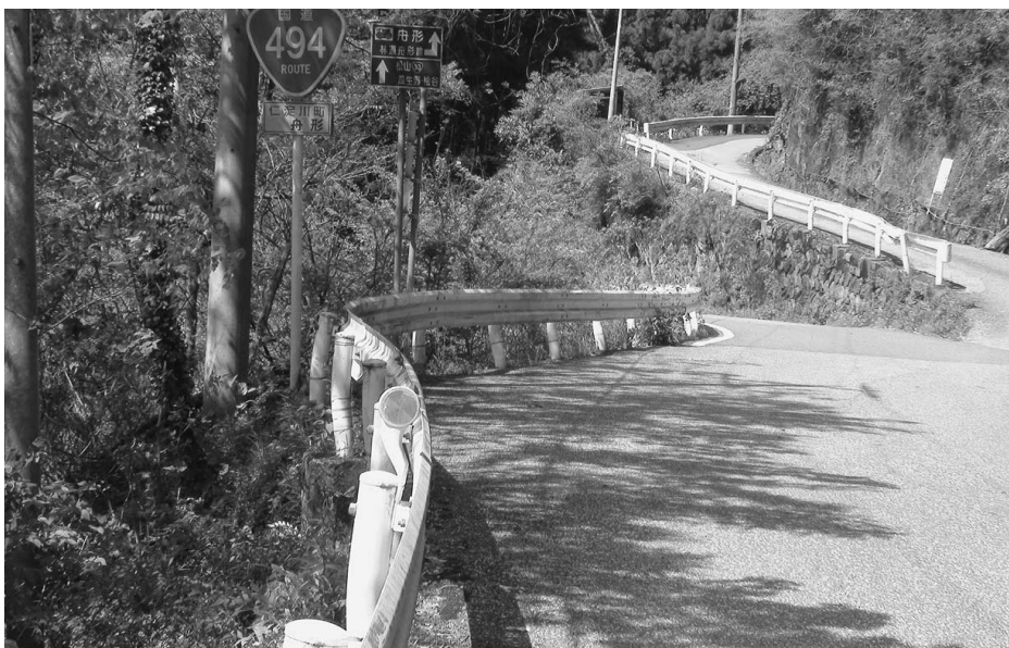
残事業量が多いため、2車線化が留保された国道494号（舟形）
