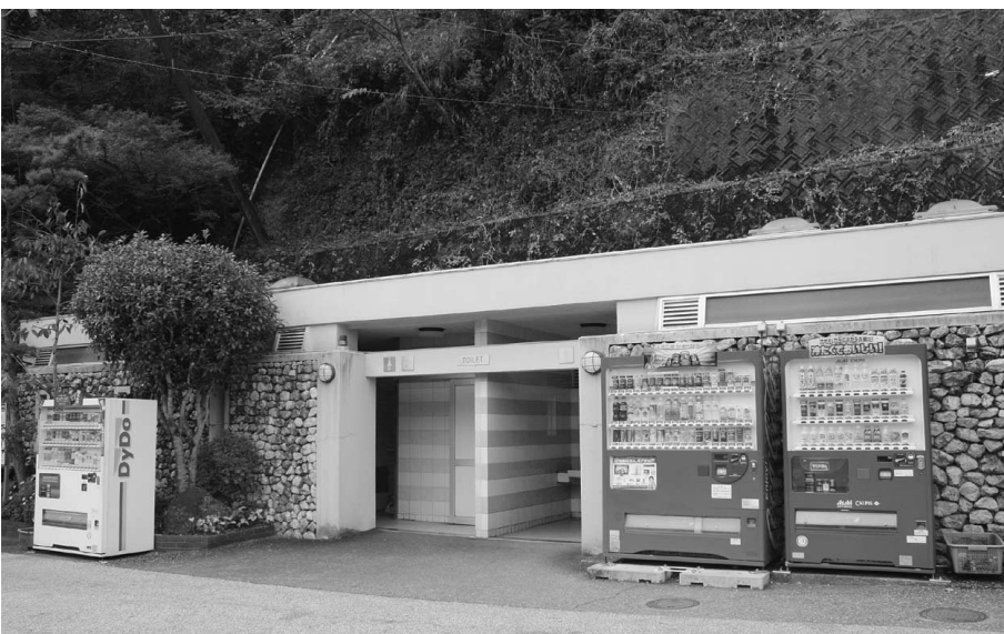
33号線唯一の「引地トイレ」ドライバーの利便性を考慮し工事費900万円で改修を図る（引地）
