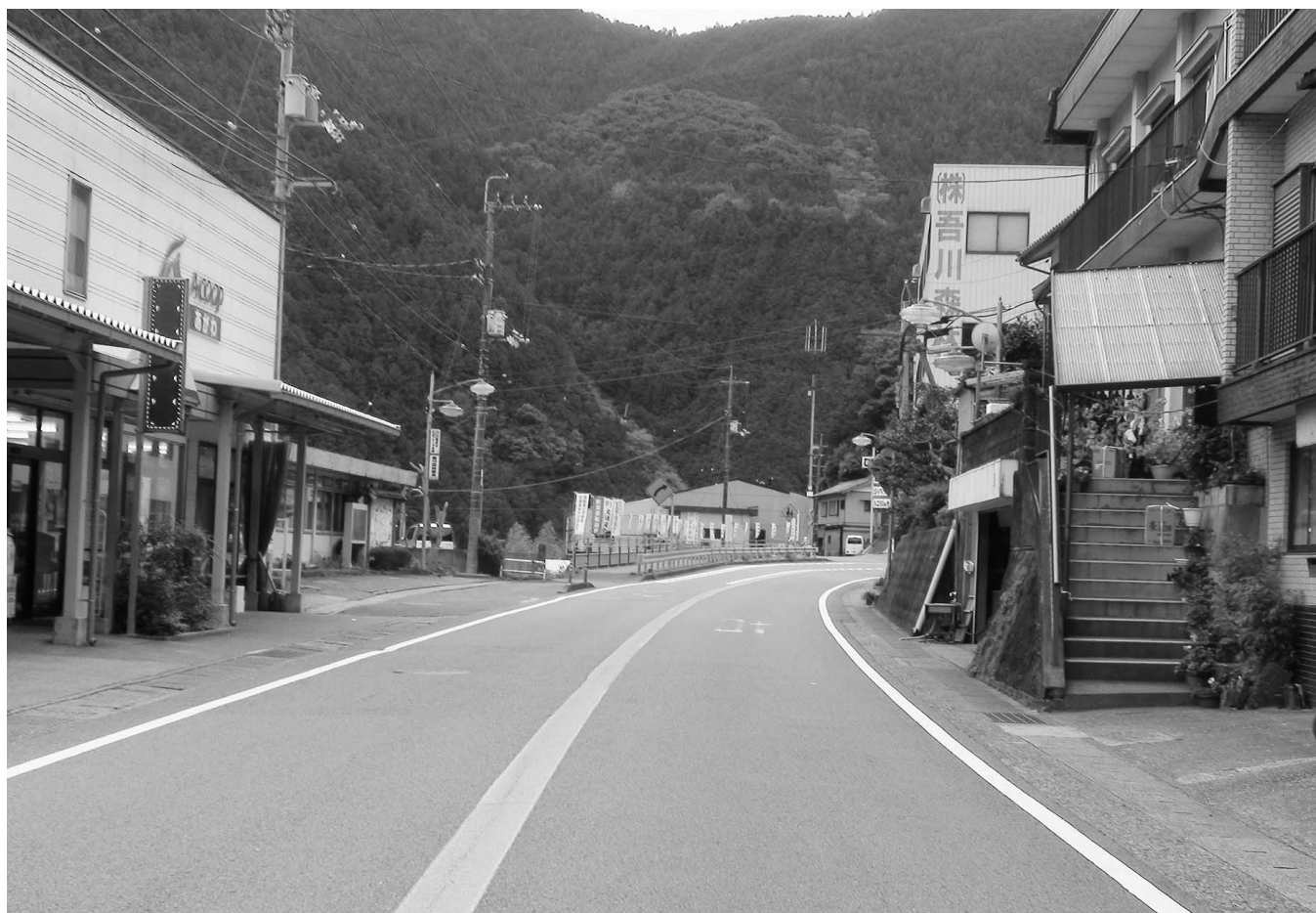
国道33号線（旧NTT前）
