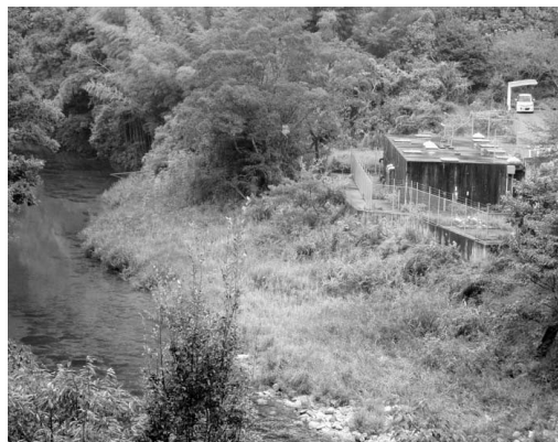
土居・竹ノ谷。取水施設
