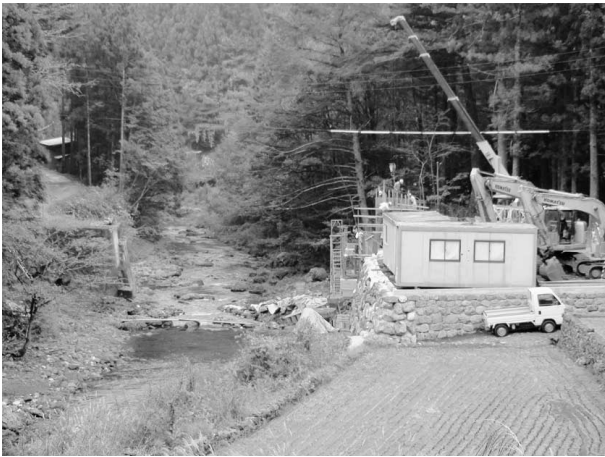
白石川線工事現場 (泉川地区)
