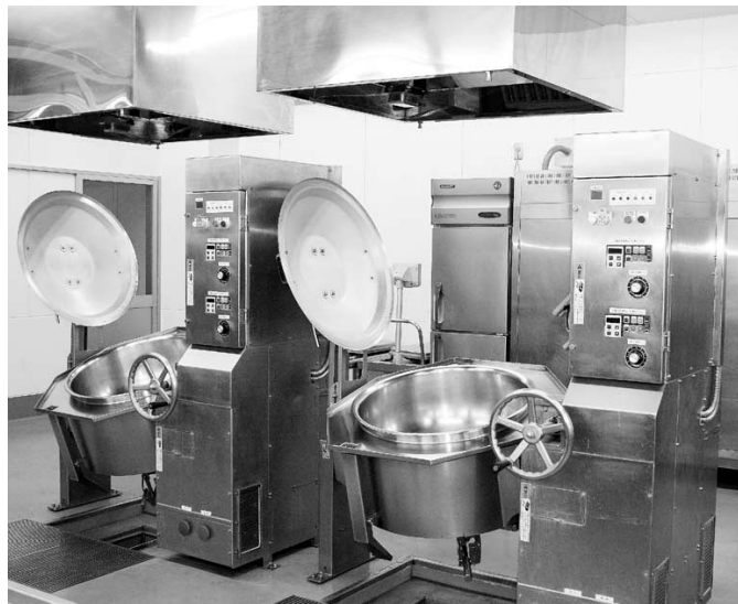
給食センター（内部）
