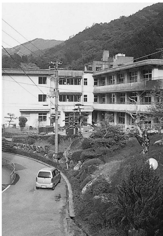
耐震工事が行われる池川中
