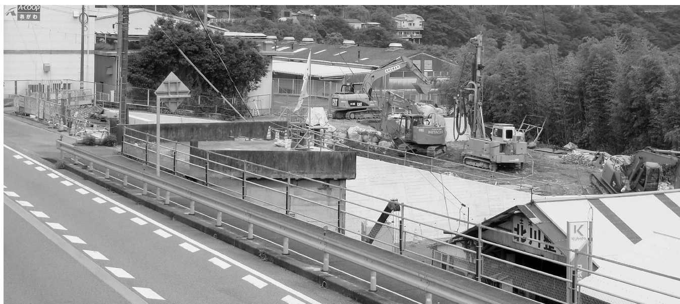
工事中の吾川地区デイスタービスセンター(大崎)
