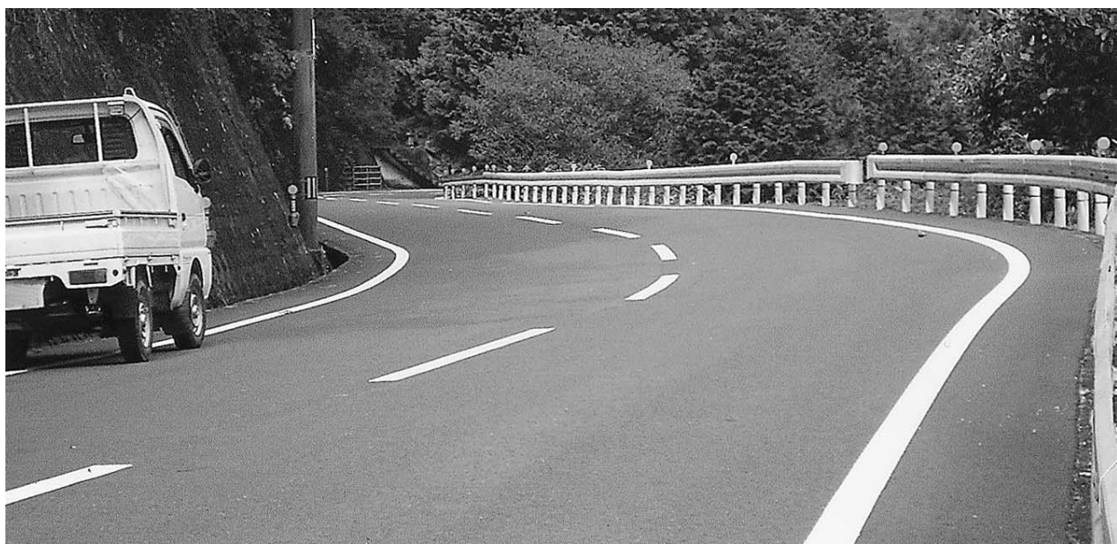
国道439号 長屋付近 カーブが多く通学には危ない
