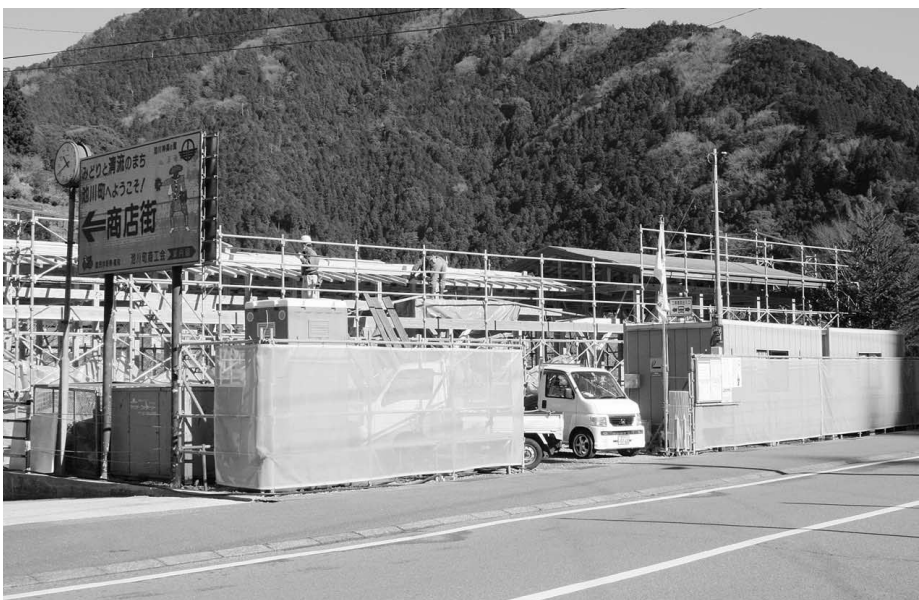
建設中の439交流館
