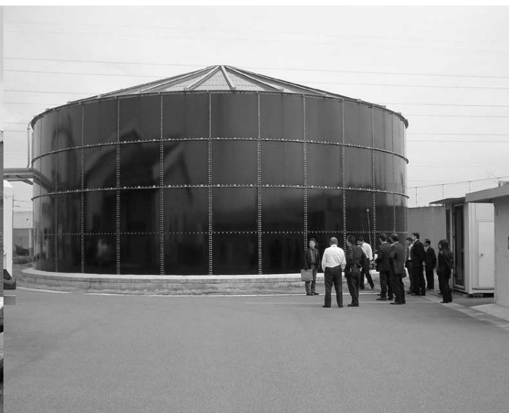
福岡県大木町循環センター
