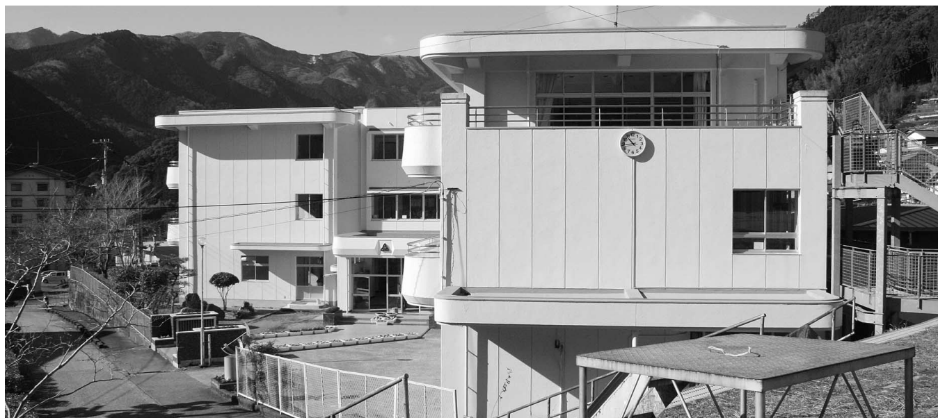
耐震工事の終了した池川中学校
