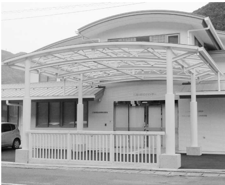
吾川地区デイサービスセンター 外観
