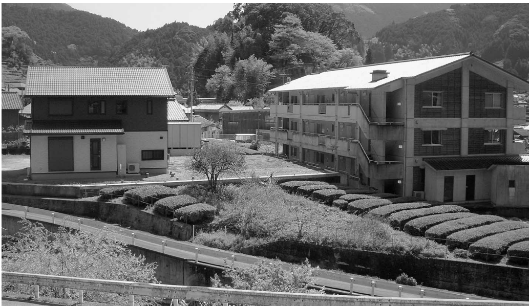
仁淀地区 若者定住地（町の土地を購入し建築中）
