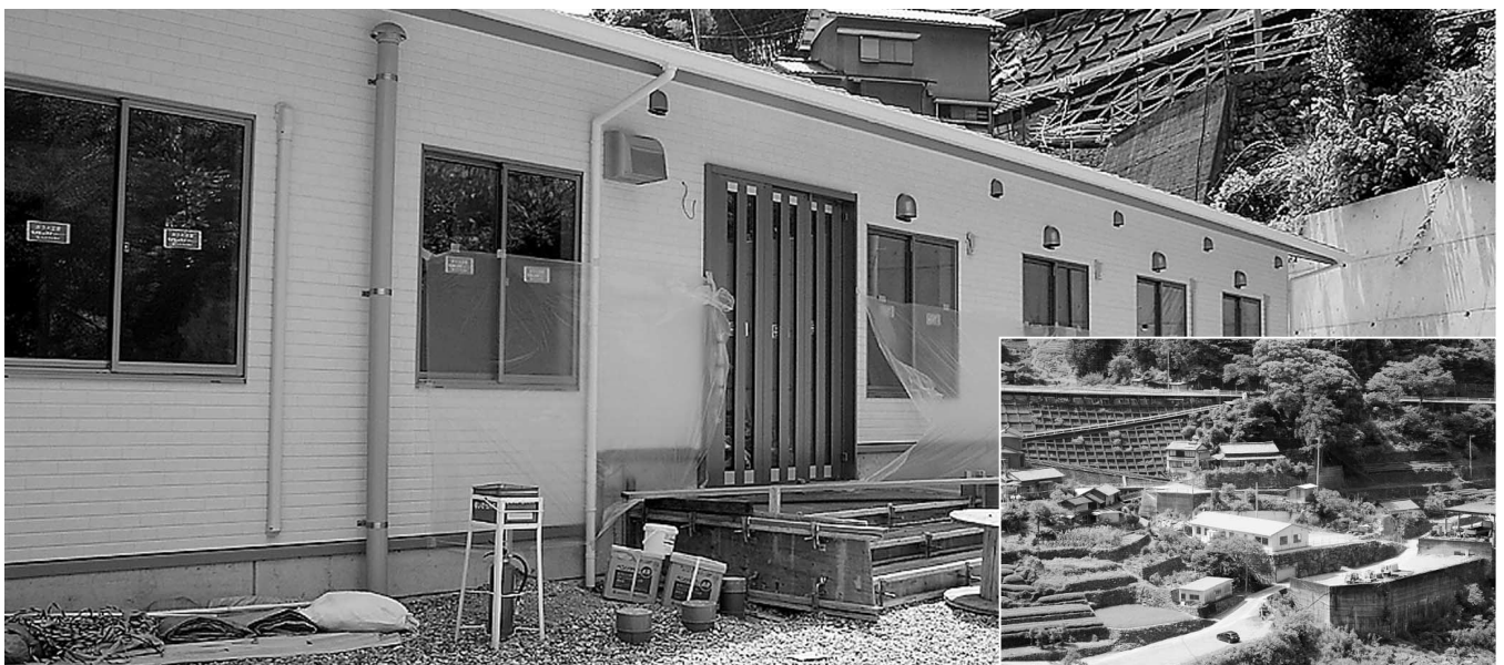
相能へ建築中のグループホーム
