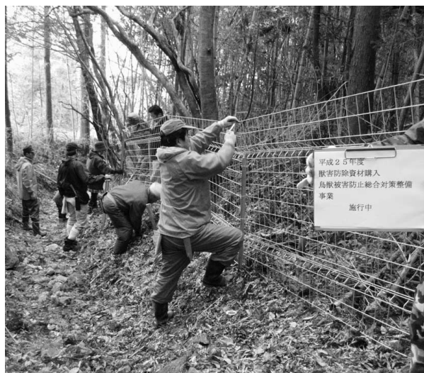
侵入防止柵設置作業
