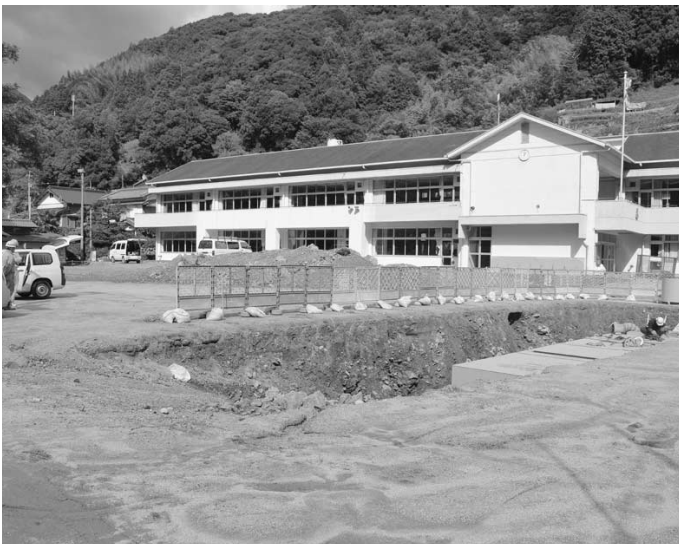
旧大崎小学校校舎等の改修
