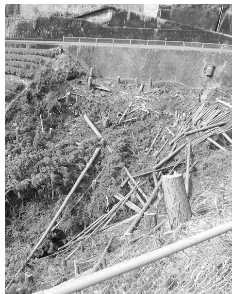
支障木を整備 道路環境を改善
