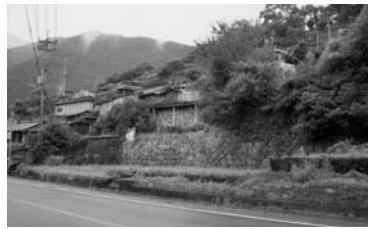
川口の購入土地 (下段＝集会所、上段＝住宅予定地)
