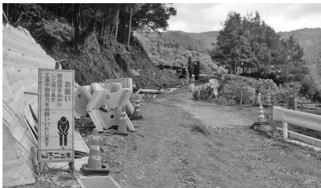
町道馬場線工事の状況
