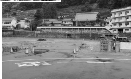
本庁舎建設予定地
