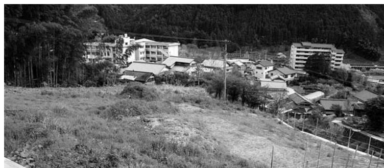
竹ノ谷地区若者定住住宅予定地（2工区）
