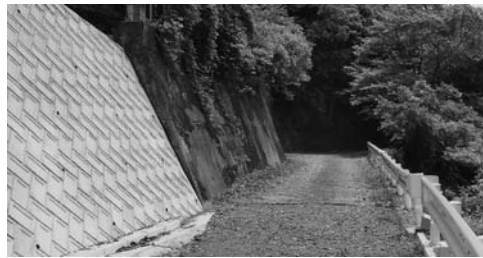
中断している大板工区
