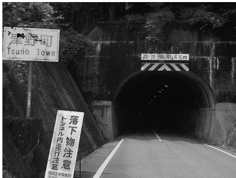
矢筈トンネル
