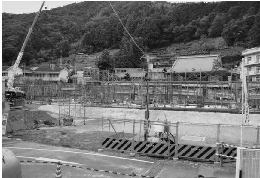
新庁舎工事現場の状況 (10月15日撮影)
