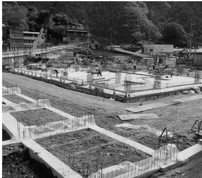
基礎工事がほぼ完了した本庁舎新築工事（10月8日現在）
